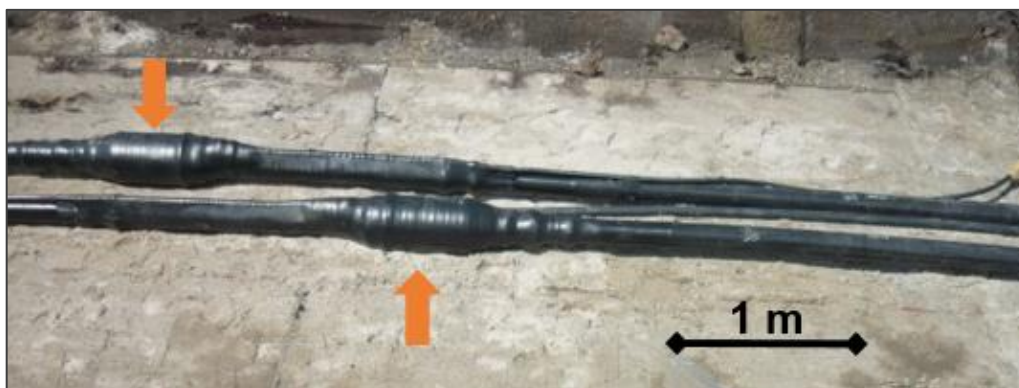
Abbildung 7: Muffen (Pfeilmarkierung) vor Wiederverfüllung des Leitungsgrabens 7
